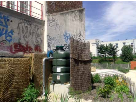
Obr. 47: Dažďový zvod napojený na nádrž, z ktorej sa voda následne využíva na polievanie (zdroj: Zuzana Hudeková)
